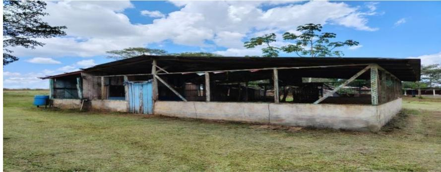
**Área techada en terreno comunal en Isla Chica:** Esta obra consiste en la construcción de 10 columnas con pedestales de 0.30x0.30x0.50 metros y tubo estructural; techo de 360m<sup>2</sup> de área (20 x 18 m), losa de concreto 25m<sup>3</sup> y cerramiento perimetral con malla ciclón. También debe incluirse la conformación de terraza en donde se ubicará la obra.
