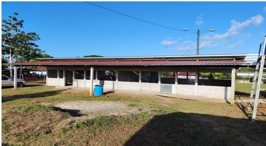
**Formulario No. 4: Construcción de área techada de 440 m2 en Salón Comunal Nueva Esperanza de Caño Negro de Los Chiles:** La obra consiste en la construcción de columnas, estructura y cubierta de techos, sistema de evacuación de aguas pluviales en salón comunal, para lo cual deben considerarse que los
