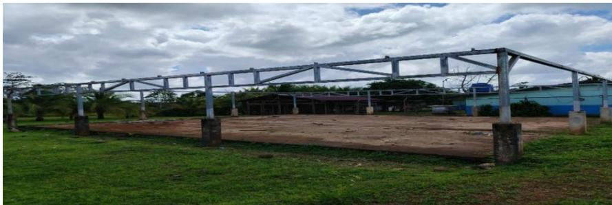
**Área techada Centro Educativo El Combate:** Esta obra consiste en la construcción de 10 columnas con pedestales de 0.30x0.30x0.50 metros y tubo estructural; techo de 360m<sup>2</sup> de área (20 x 18 m), losa de concreto 25m<sup>3</sup> y cerramiento perimetral con malla ciclón. La comunidad demolerá y limpiará la totalidad del área para que el contratista inicie la nueva construcción.
